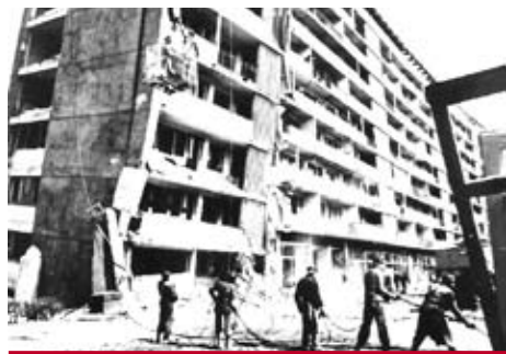
Prăbușirea unei secțiuni cu parter flexibil din Blocul 30, tronsonul A, Lizeanu, Șos. Ștefan cel Mare
