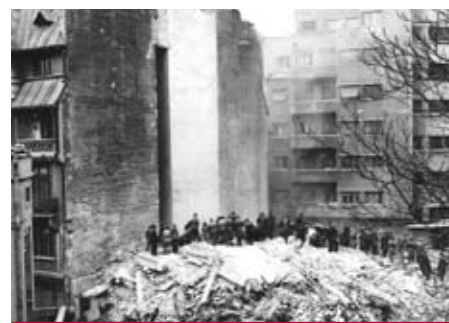
Imagine standard a dezastrului: prăbușirea “sandwich” în 1977 a unei structuri construite înainte de 1940 (Bd. Hristo Botev, nr. 10)
