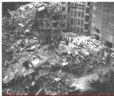
Prăbușirea „sandwich” a blocurilor construite înainte de 1940 de la Colanade - Str. Ion Ghika, loc în care au pierit, printre alții, Toma Caragiu și Doina Badea
